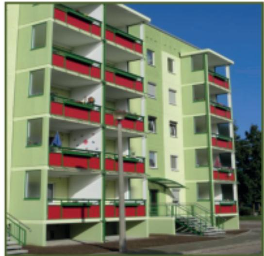
Die neuen Balkone sind größer und gewährleisten durch die an den Seiten eingebrachten Fenster einen besseren Lichteinfall auf den Balkonen und in den dahinterliegenden Räumen.
